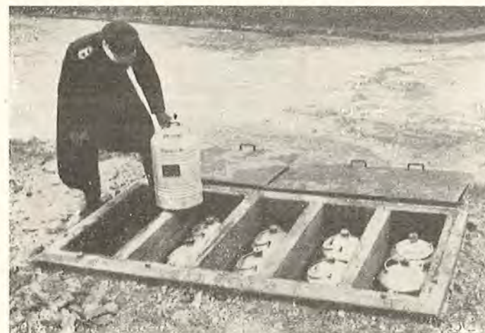
Fig. 38. Grube i det fri til opbevaring af vædsker i fareklasse I.
