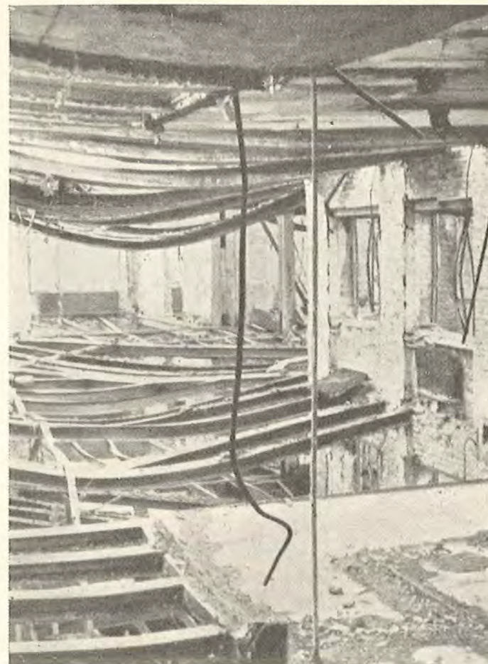
Fig. 10. Stålbjælker og betondele efter brand (Shell-huset).
