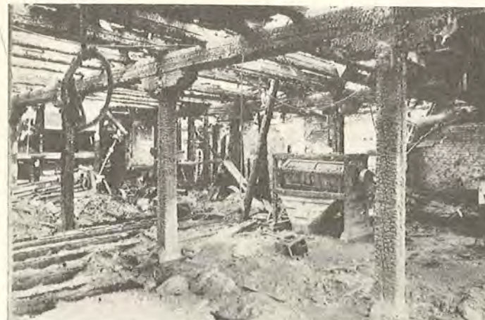
Fig. 16. Trækonstruktion efter brand.
