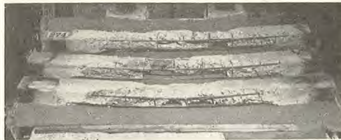
Fig. 11. Jernbetonsøjler efter brandforsøg.
