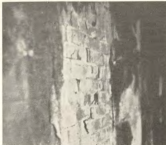
Fig. 15. Beton og mur efter brand.
